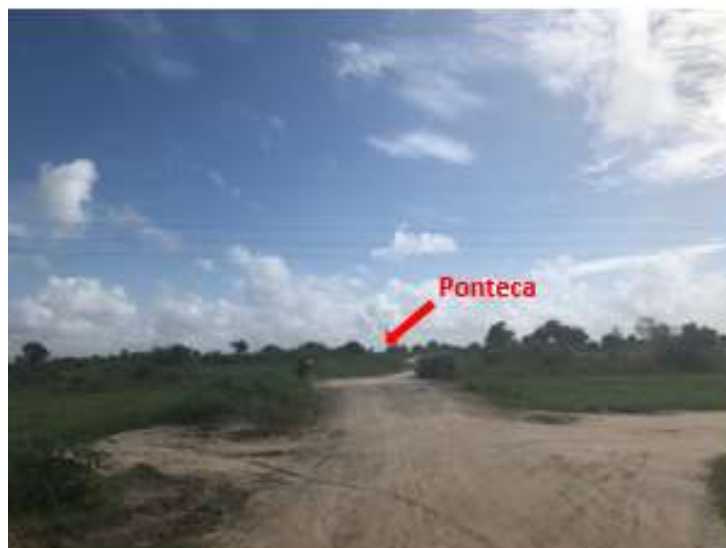
Figura 57 – Ponteca na estrada de acesso à área do Projecto
